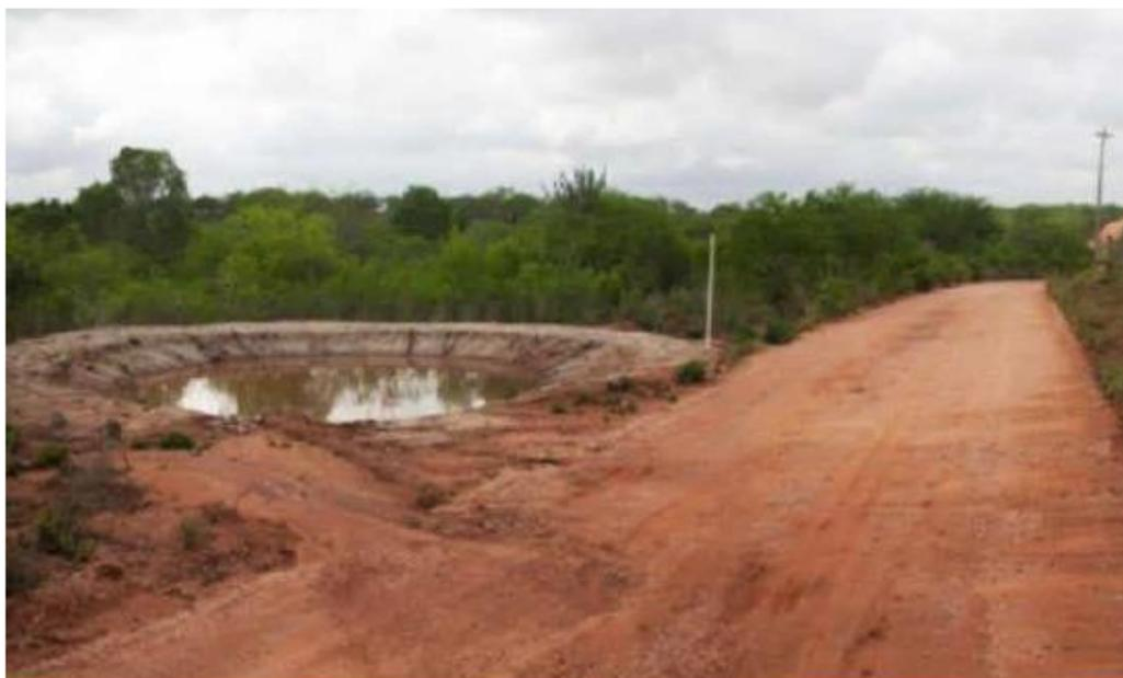
**Figura 13:** Exemplo estrada readequada consorciada com construção de barraginhas.
